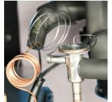
La soupape de dérivation de gaz chaud a pour objectif principal d'empêcher le condensat de geler à la surface du serpentin de l'évaporateur lorsque le système fonctionne à des conditions de charge extrêmement basses.
